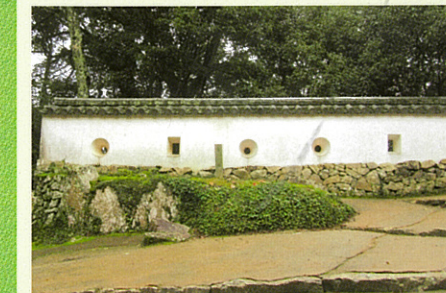
三の平櫓東土堀 (重要文化財)
